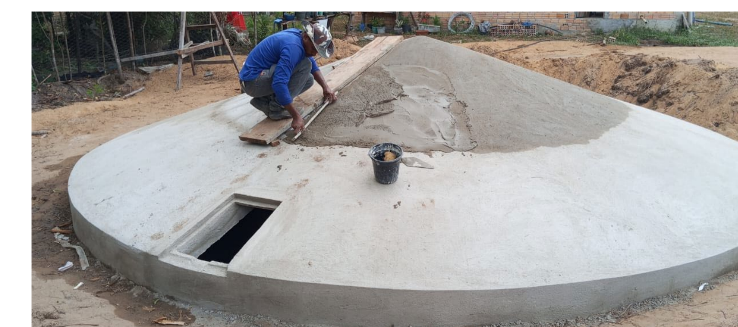
Fotos: Processo de construção das cisternas de placa para captação de água da chuva.
