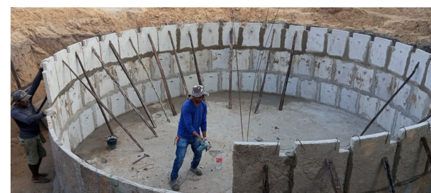
Fotos: Processo de construção das cisternas de placa para captação de água da chuva.
