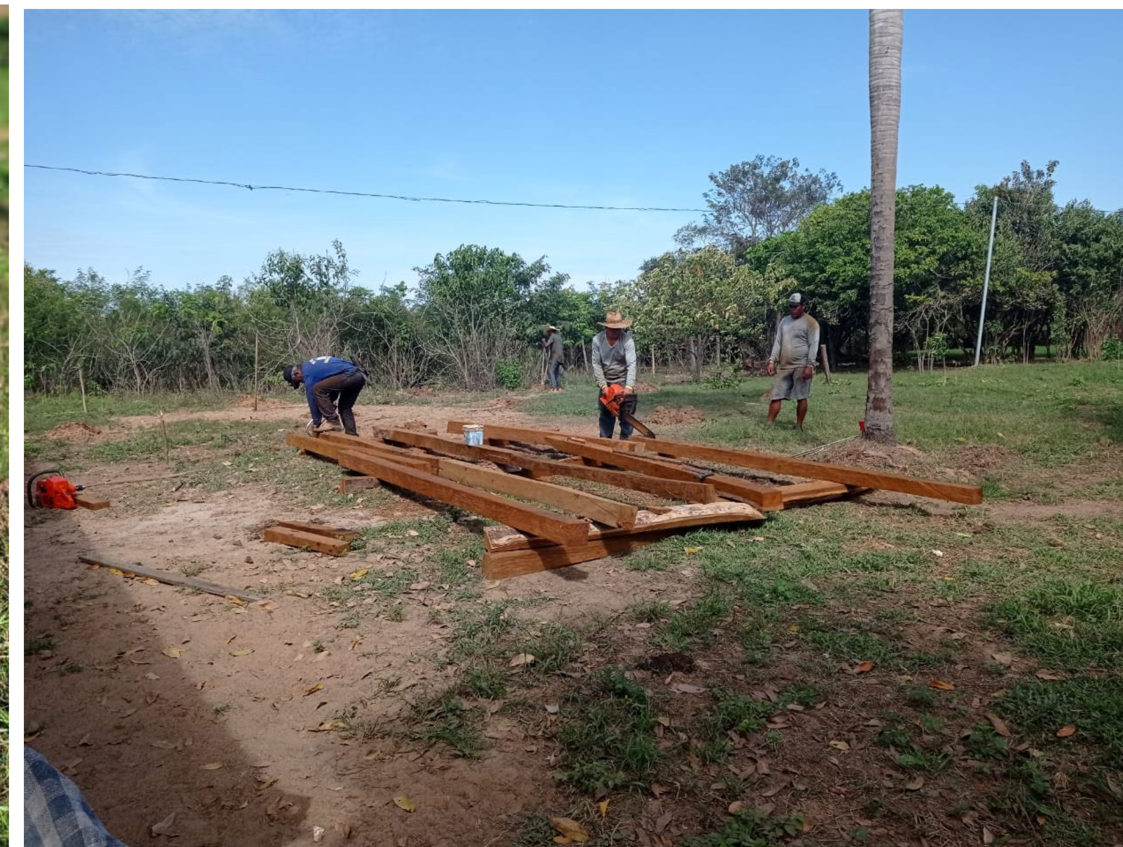
Foto 3. Início da construção.
